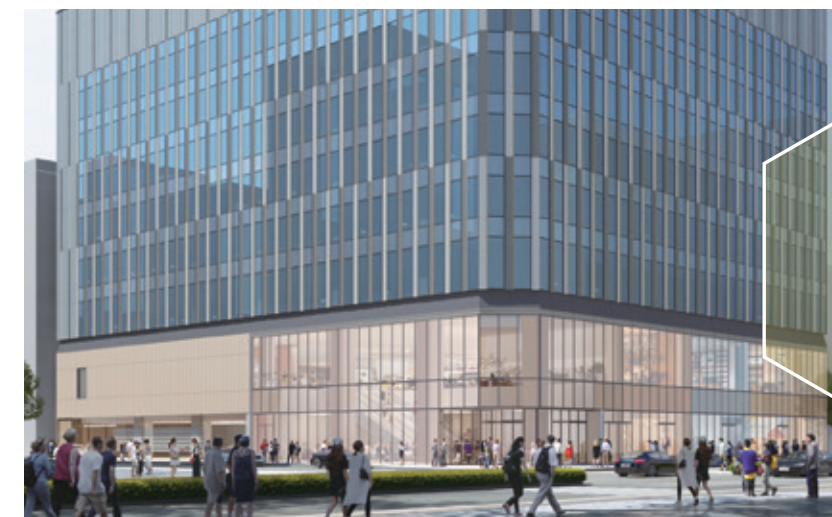
1・2階商業エリア外観（駅前通り側）
