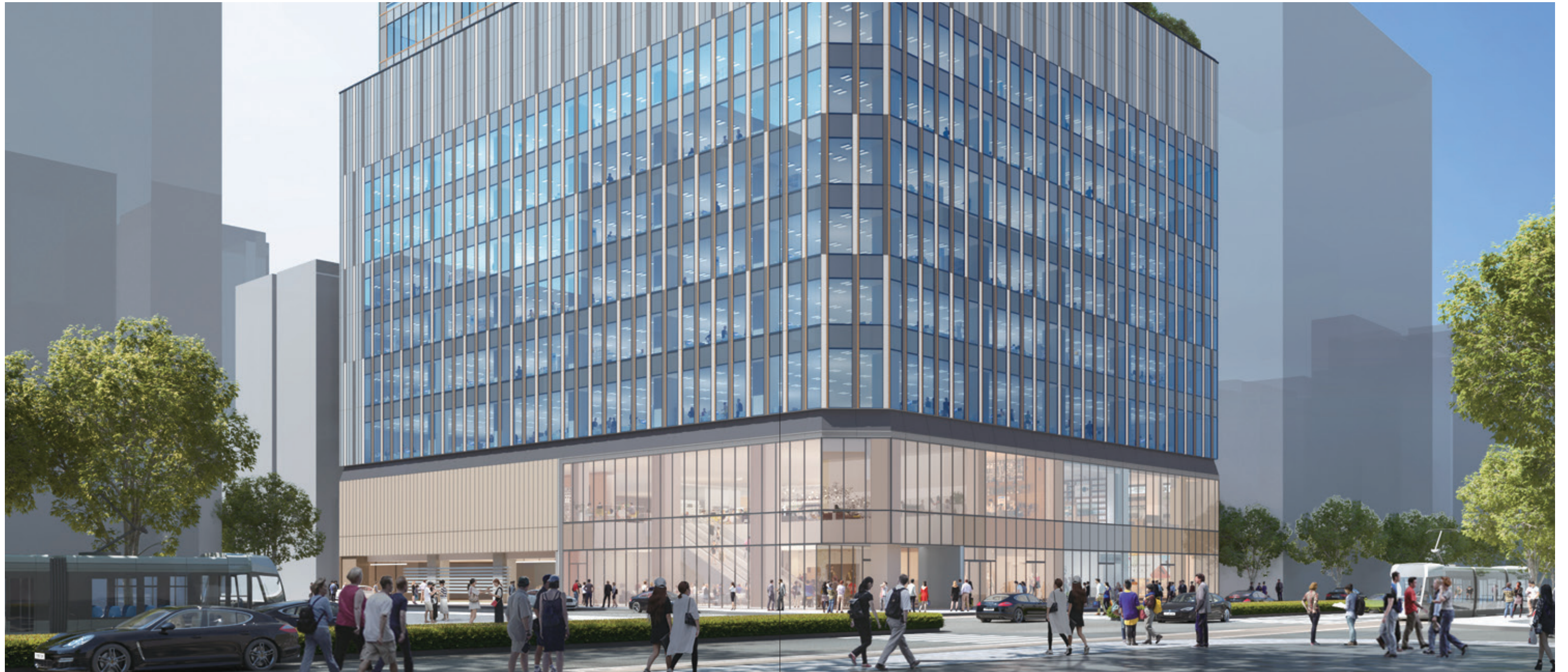
1階エントランス外観
