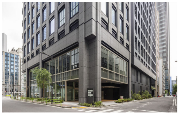
【地下1階八重洲地下街接続部】
