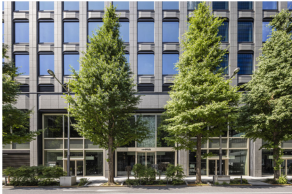
【1階エントランスホール】
